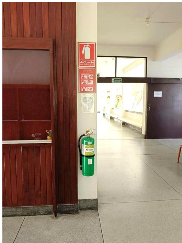
อาคาร 4 สำนักศูนย์ภาษา และ อาคาร 14 อาคารปฏิบัติการคอมพิวเตอร์
